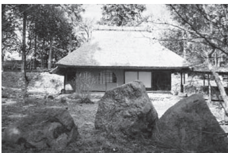
五峰庵屋根修復の様子と葺替えが完了した外観
